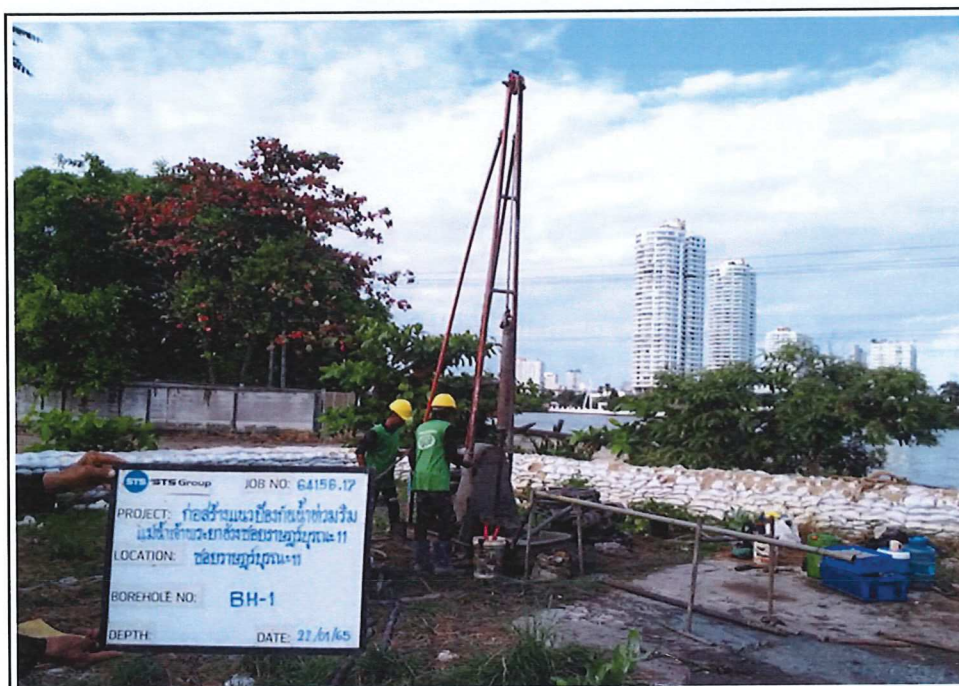
ภาพถ่ายแสดงเครื่องเจาะดิน ชนิด PORTABLE DRILLING RIG บริเวณหลุม BH-1
