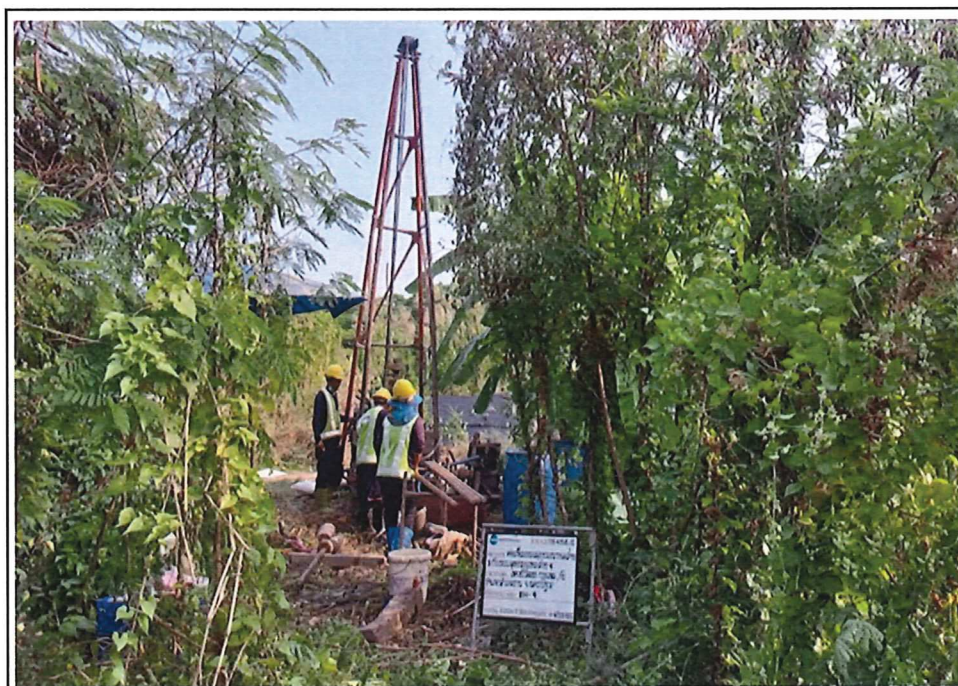
ภาพถ่ายแสดงเครื่องเจาะดิน ชนิด ROTARY DRILLING RIG
