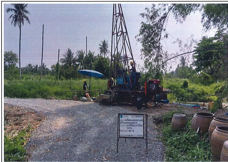
ภาพถ่ายแสดงเครื่องเจาะดิน ชนิด ROTARY DRILLING RIG บริเวณหลุม BH-1
