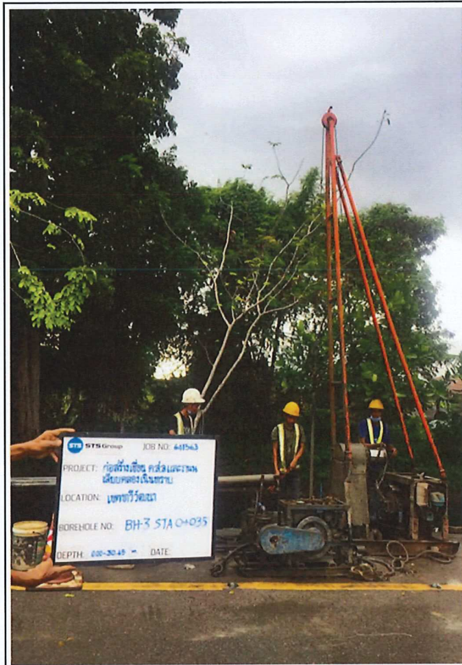
ภาพถ่ายแสดงเครื่องเจาะดิน ชนิด PORTABLE DRILLING RIG บริเวณหลุม BH-3
