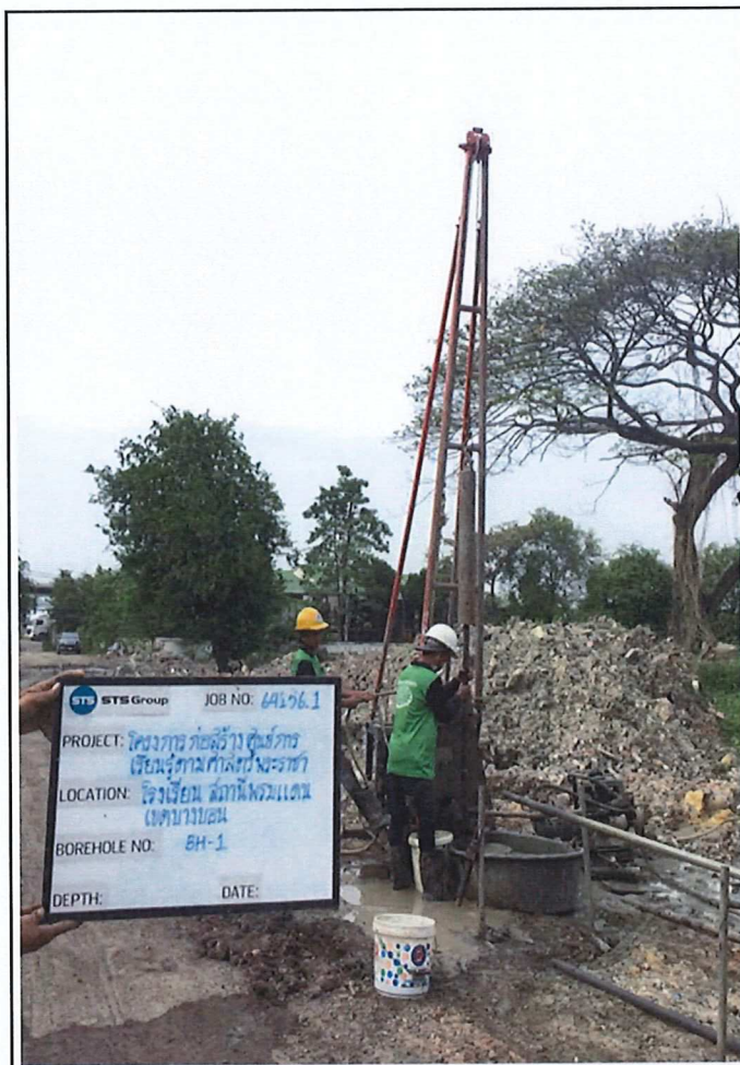
ภาพถ่ายแสดงเครื่องเจาะดิน ชนิด PORTABLE DRILLING RIG บริเวณหลุม BH-1
