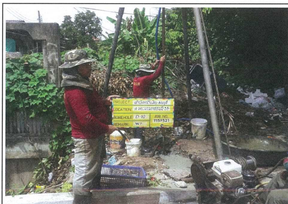
ภาพถ่ายแสดงตำแหน่งหลุมเจาะ D-10
