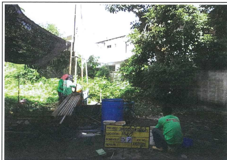
ภาพถ่ายแสดงตำแหน่งหลุมเจาะ D-7
