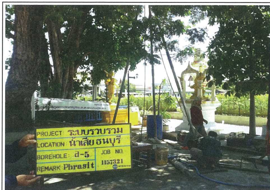
ภาพถ่ายแสดงตำแหน่งหลุมเจาะ D-5
