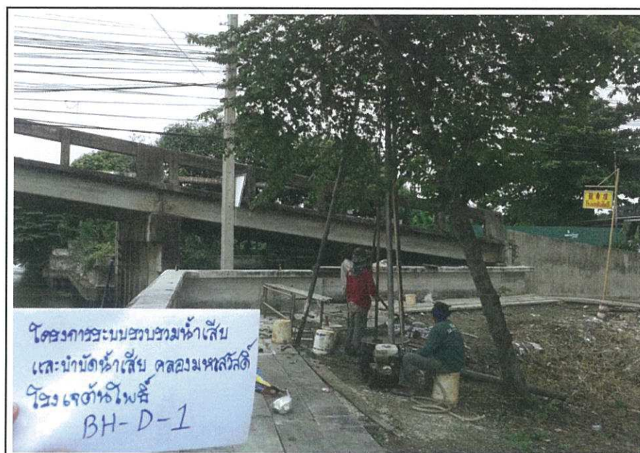
ภาพถ่ายแสดงตำแหน่งหลุมเจาะ D-1
