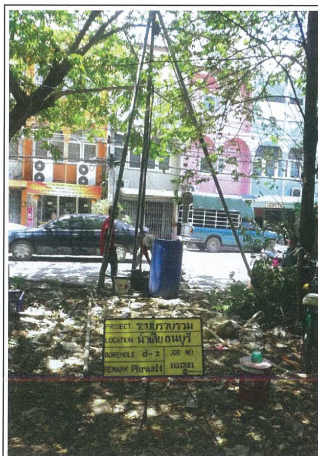
ภาพถ่ายแสดงตำแหน่งหลุมเจาะ D-2
