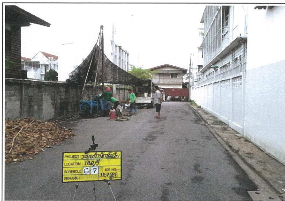
ภาพถ่ายแสดงตำแหน่งหลุมเจาะ C-7
