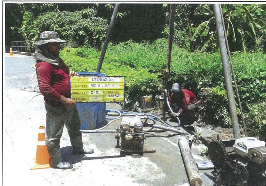
ภาพถ่ายแสดงตำแหน่งหลุมเจาะ C-5
